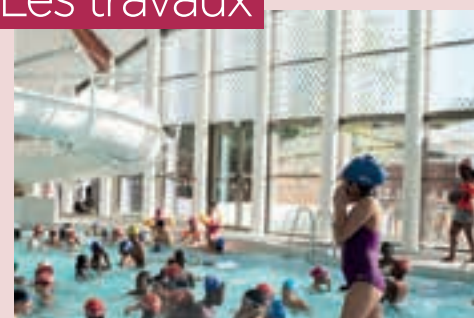
>>> Remplacement des façades vitrées pour une meilleure performance énergétique
