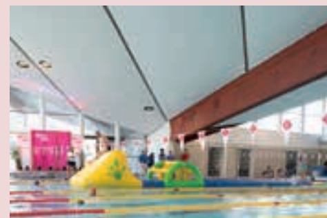
>>> Rénovation complète de la toiture
